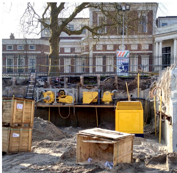
Bouwput met bemaling in de directe omgeving van een monument.
